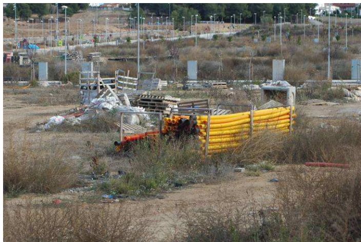
Vista del Parc Central de Roquetes. Obra finalitzada
